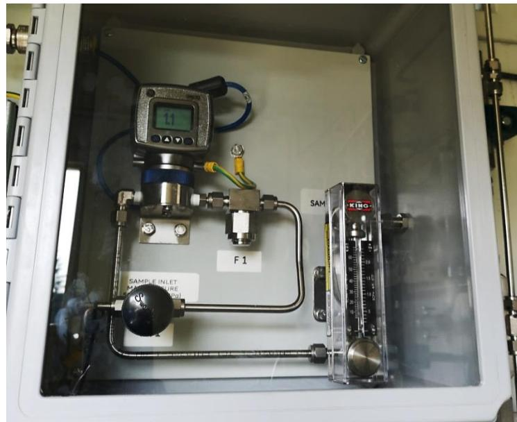
**Slika 5-13.** Oxy.IQ analizator za mjerjenje udjela kisika u plinu
