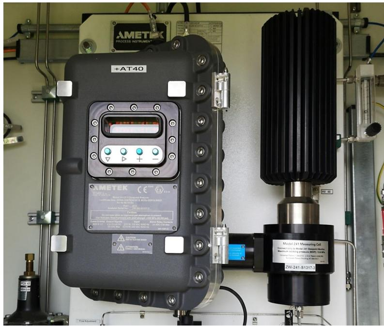
Slika 5-11. Ametek, analizator za mjerjenje rosišta ugljikovodika
