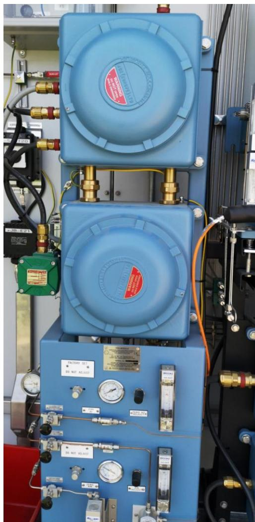
**Slika 5-12.** 700XA kromatograf za mjerjenje udjela sumpornih spojeva
