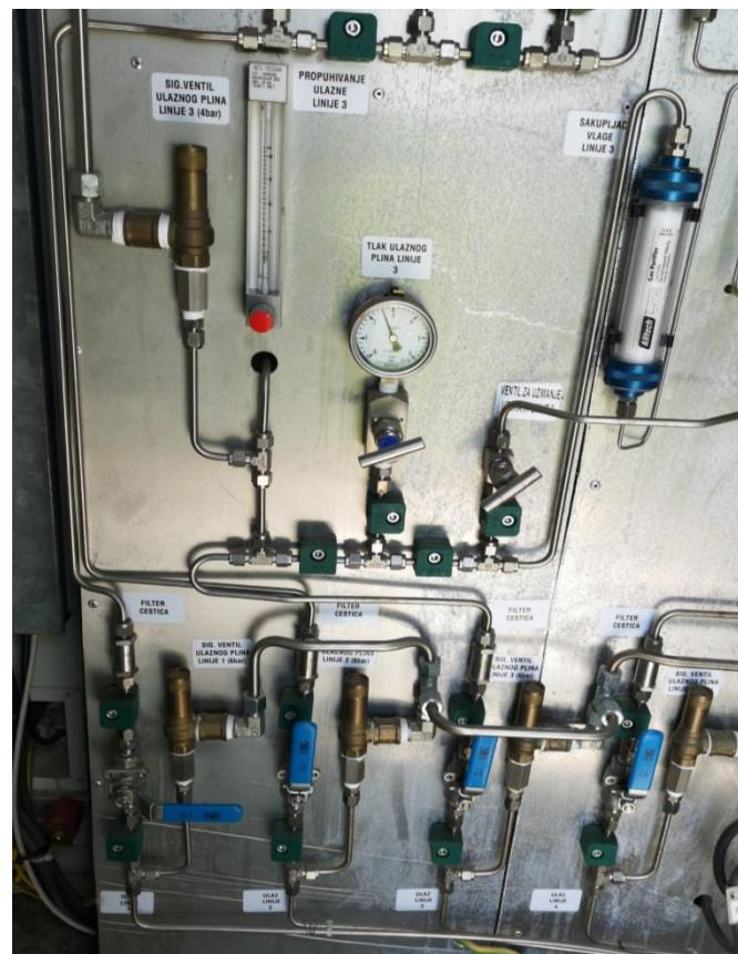
Slika 5-3. Sustav za obradu uzorka
