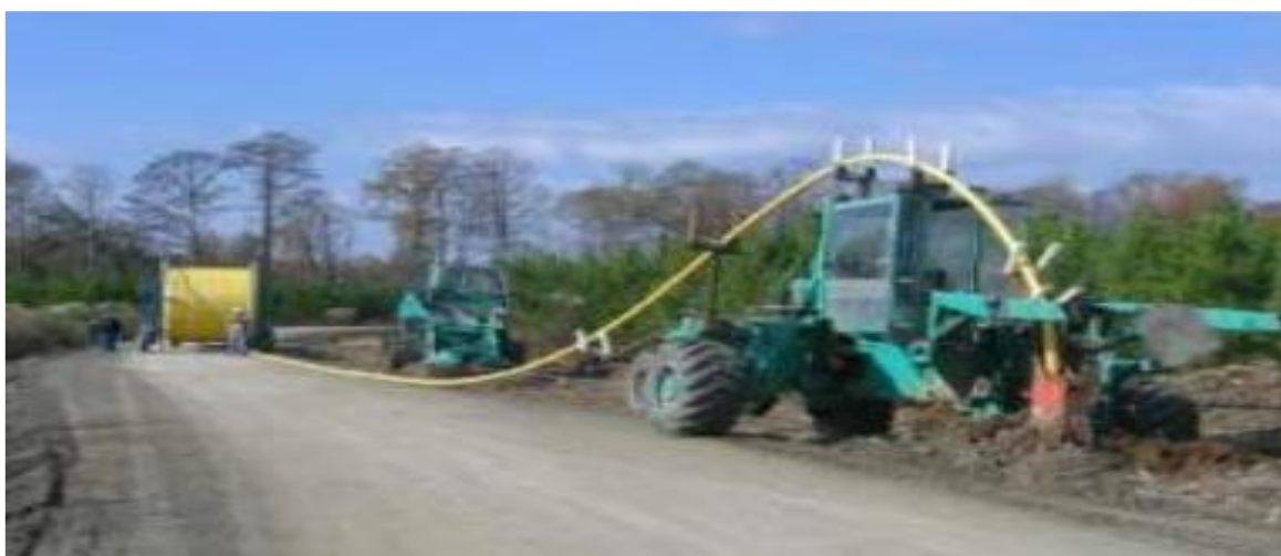
Slika 3-3. Ugradnja termoplastičnih kompozitnih cijevi na kopnu (Cheldi i ostali, 2019)
