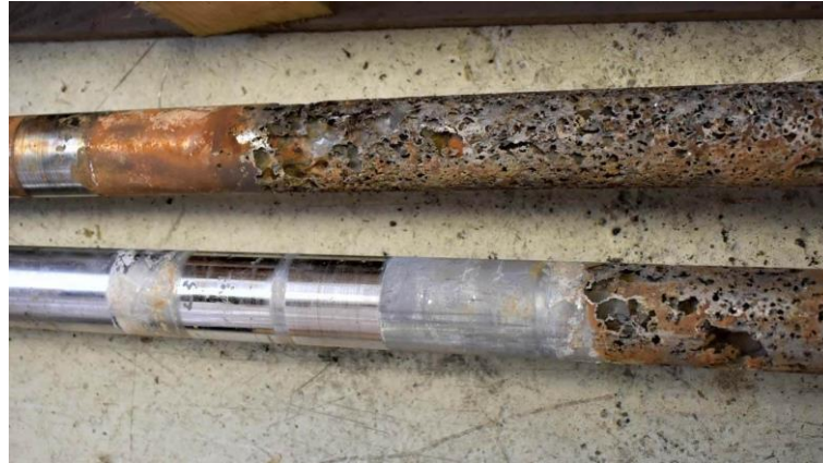
Slika 3-4. Primjer maritimne korozije (burzantike.com, 29.07.2020.).
