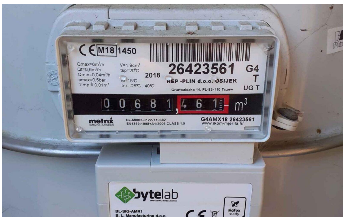
Slika 6-3. Membransko plinsko brojilo s Byte Lab senzorskim modulom za očitavanje (www.netokracija.com, 2020)
