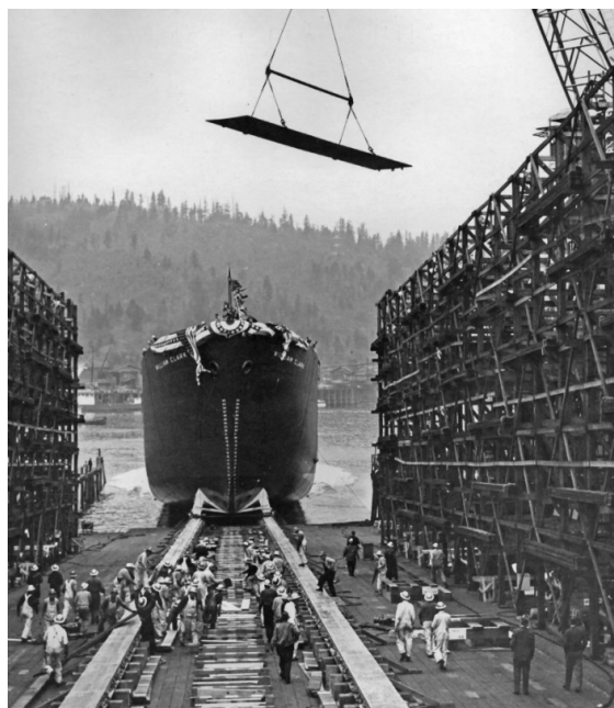
Slika 6.1. Uzdužno porinuće na kosom navozu
