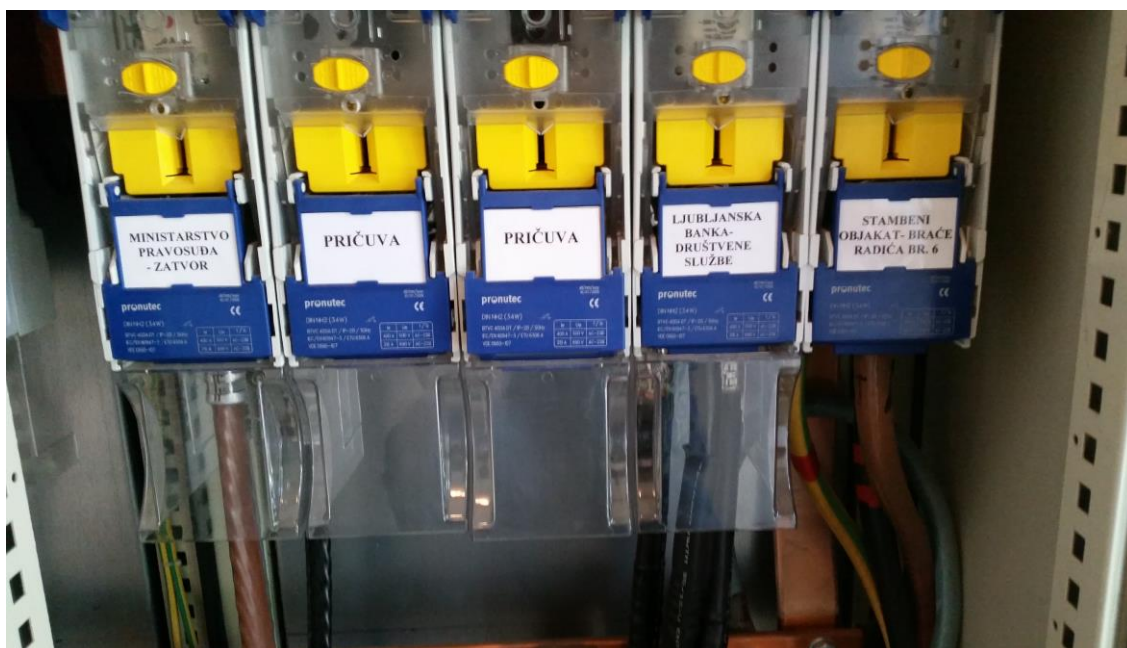
Slika 4.5. Prikaz NN izlaza iz TS Trakošćanska 5 [15]
