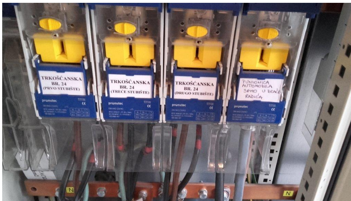
Slika 4.4. Prikaz NN izlaza iz TS Trakošćanska 5 [15]
