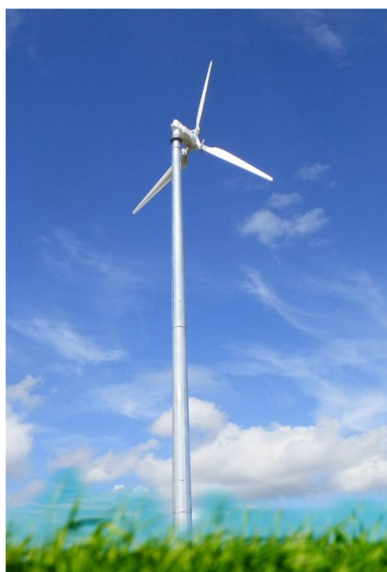
Slika 4.4 Izvedba sa stupom postavljenim ispred lopatica [17]
