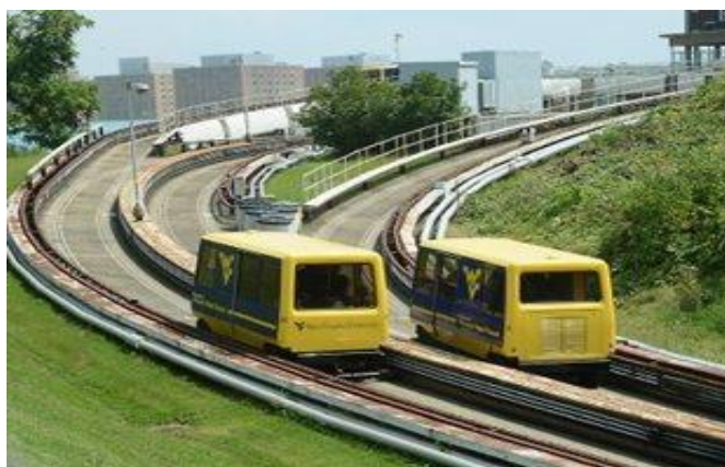
Slika 16. Prvi PRT sustav u Morgantownu
