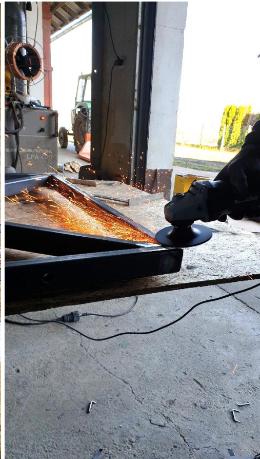
Slika 76. Brušenje zavora na čeonim spojevima
