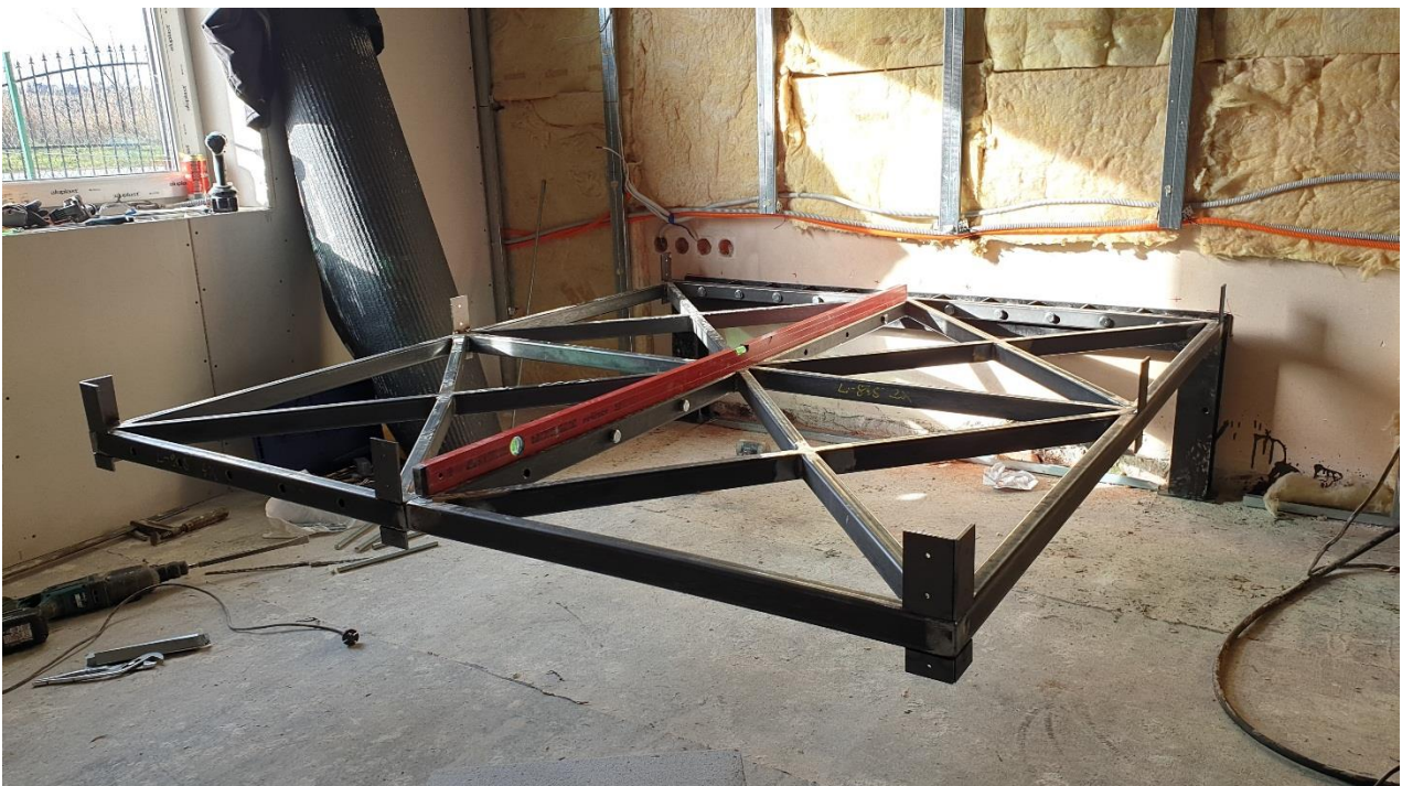
Slika 81. Završetak montaže nosive konstrukcije i konzolne potpore (1)
