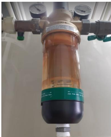
Slika 3.2. Pred priprema gradske vode s 25 \mu\text{m} filterom (vlastiti izvor)
