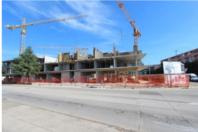
Slika 8. Gradilište ograđeno zaštitnom ogradom (izvor: web)
