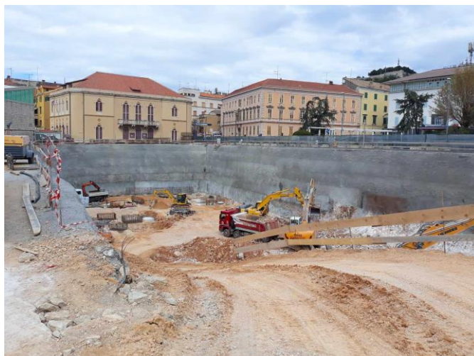
Slika 6. Odvoz viška materijala s gradilišta (izvor: vlastita slika)
