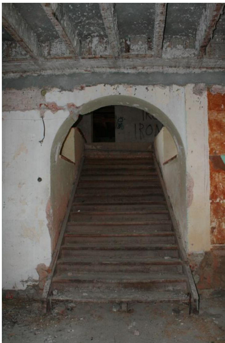
Slika 4.19. Postojeće drveno stubište
