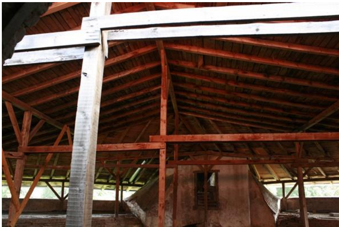
Slika 4.8. Privremena drvena nadstrešnica
