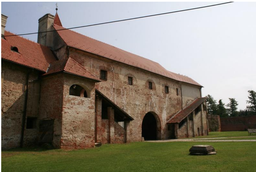
Slika 3.8. Dva bočna stubišta ulaznog bastiona
