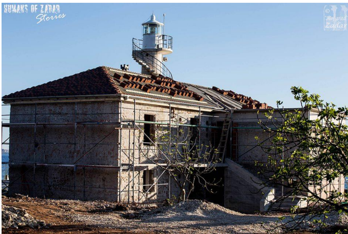
Slika 5. Obnova devastirane zgrade svjetionika
