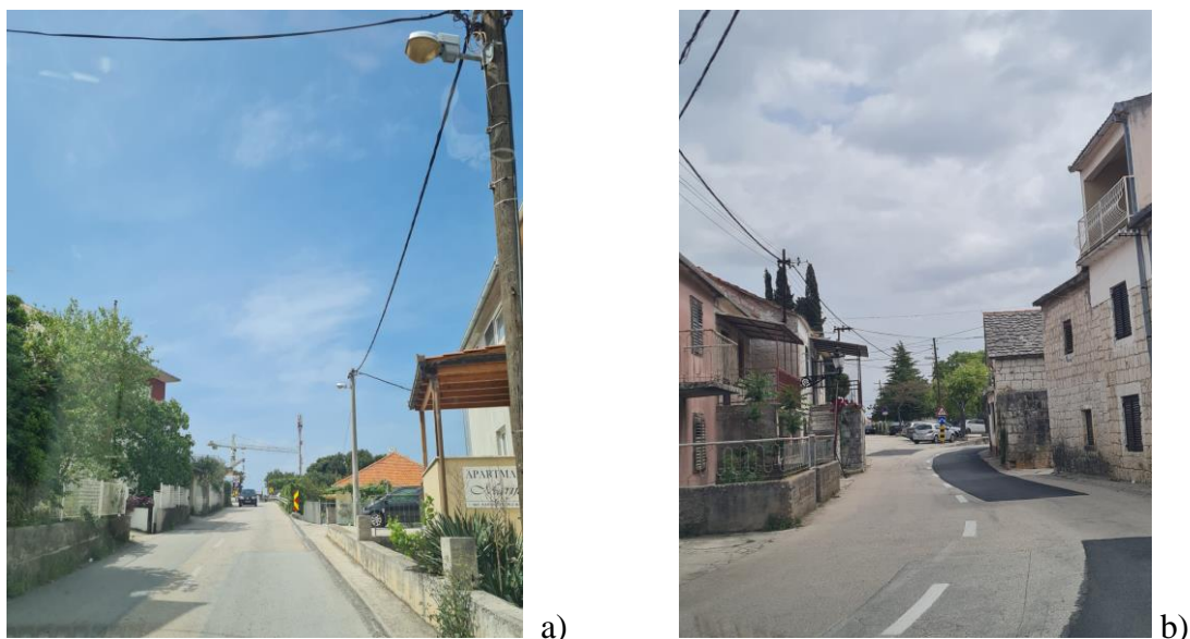
Slika 24. Primjeri suženih dvosmjernih ulica na otoku Čiovu (a,b)
