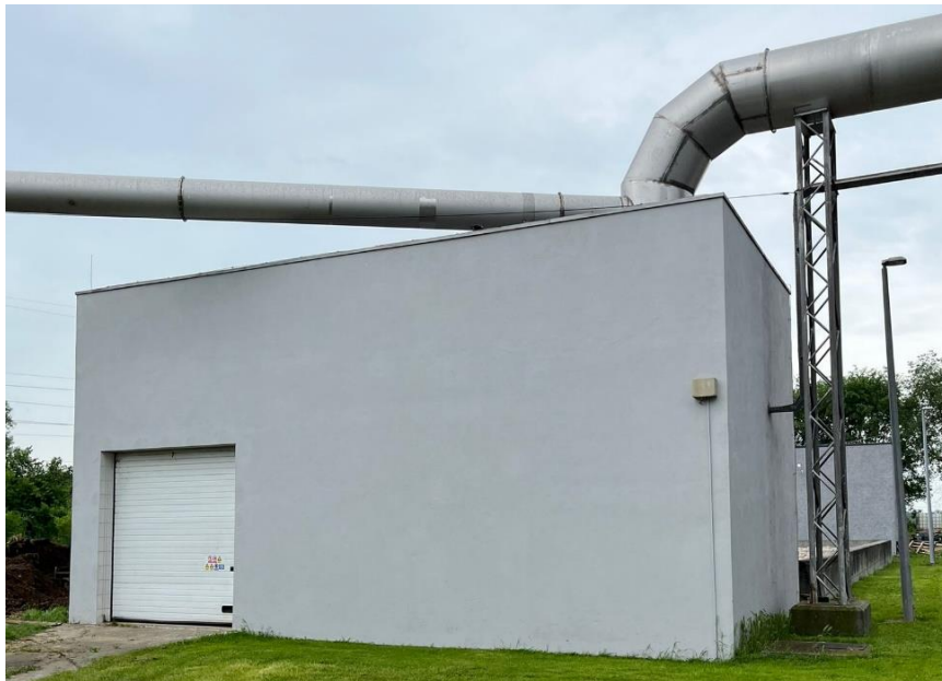
Slika 18. Biofilter pogona za preradu materijala kategorije 1 i 2 (foto: Josipa Lovasić)
