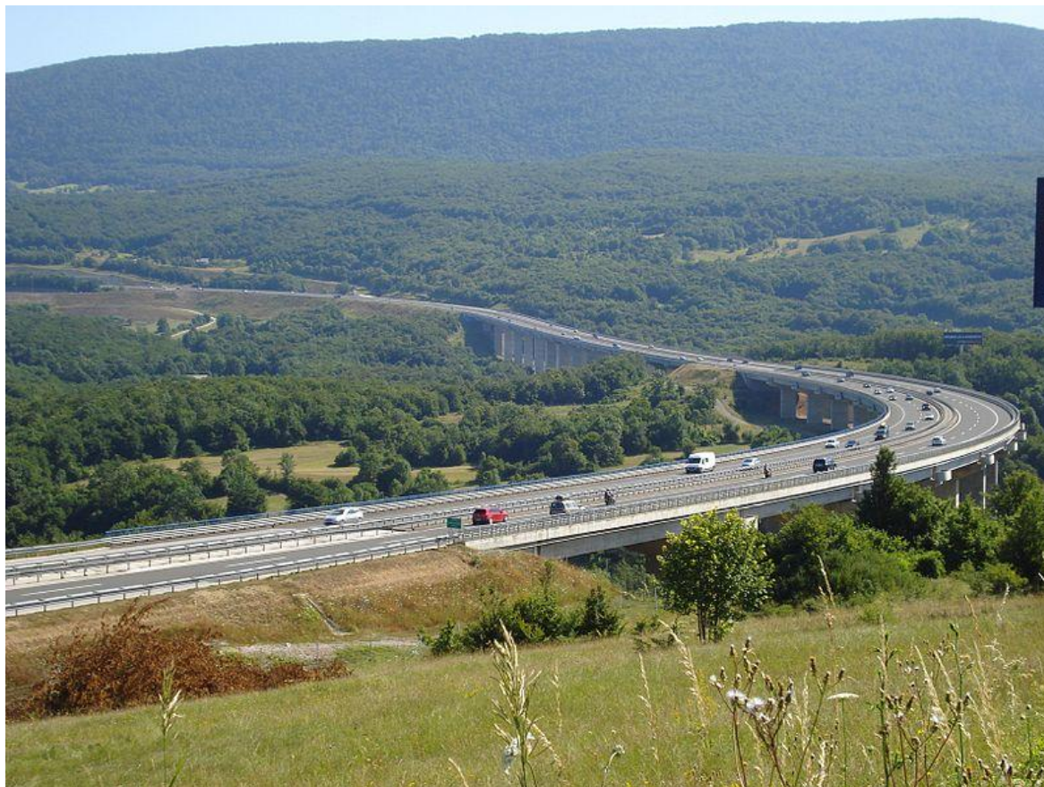
Slika 9. Autocesta A1 (Zagreb-Split-Dubrovnik), vijadukt Jezerane
