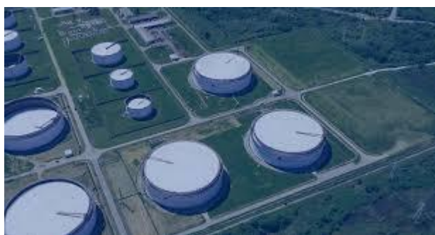
Slika 10. Rezervoar za skladištenje u Sisku
