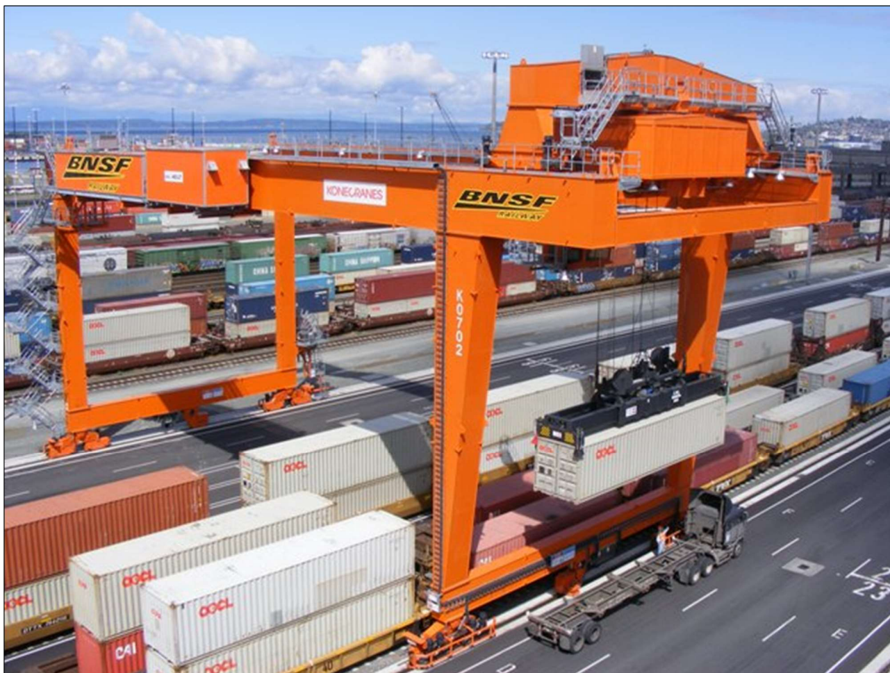
Slika 9 - Dizalica RMG na tračnicama
