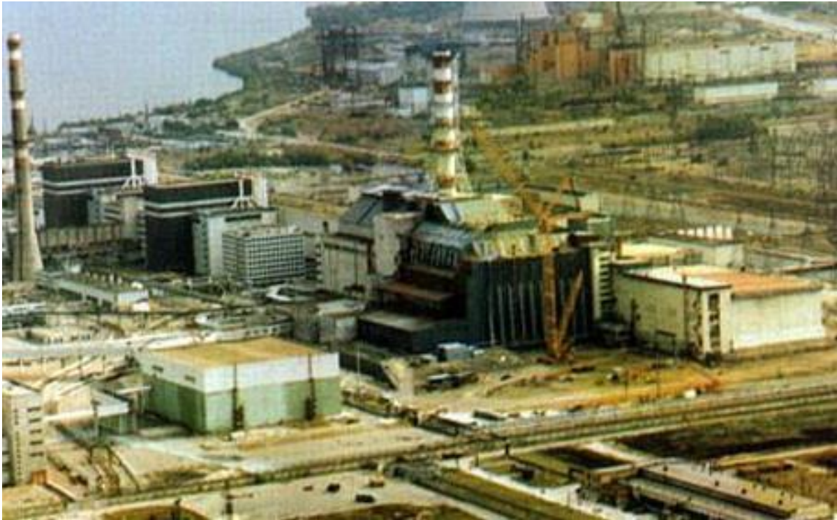
Slika 16. Černobil danas. Na sredini slike je betonski sarkofag koji okružuje kobni reaktor broj četiri.
