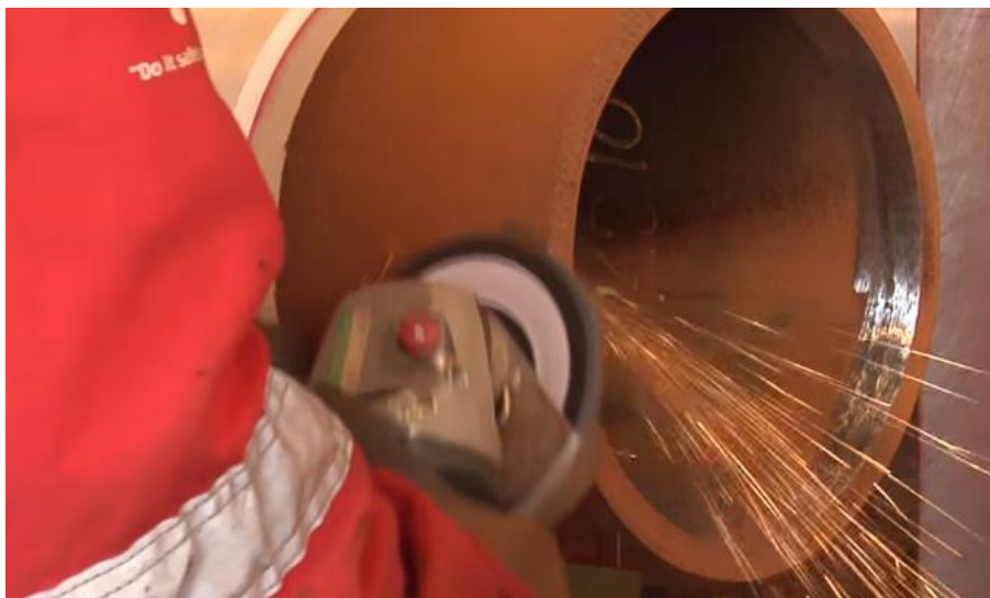
Slika 17. Priprema spoja za zavarivanje – čišćenje od korozije
