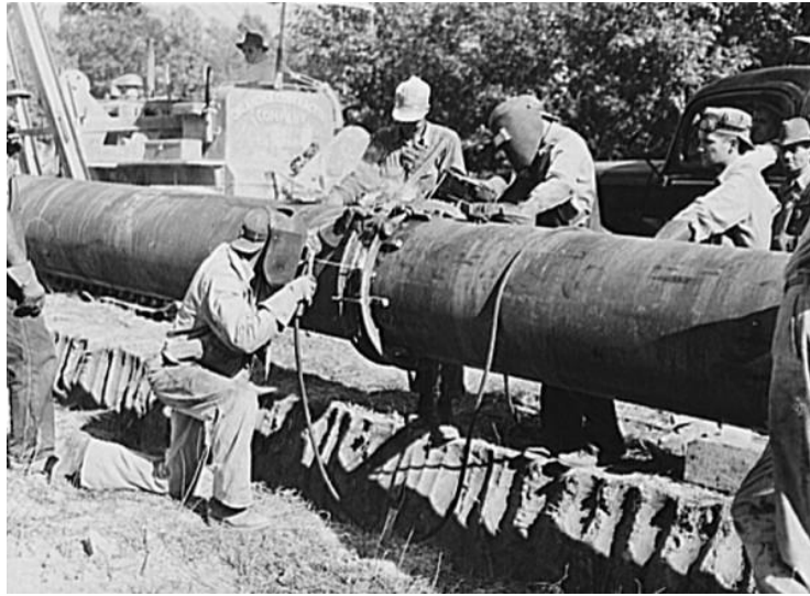
Slika 1. 1942. godina, zavarivanje cjevovoda velikih dimenzija [4]
