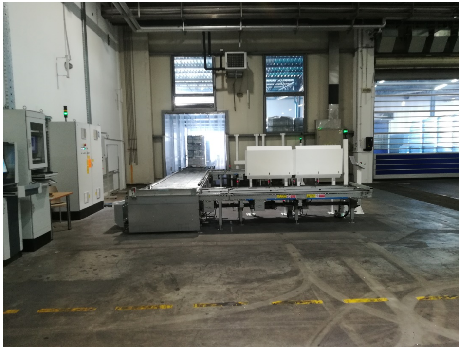
Slika 10. Transportni tunel iz proizvodnog pogona prema skladištu.
