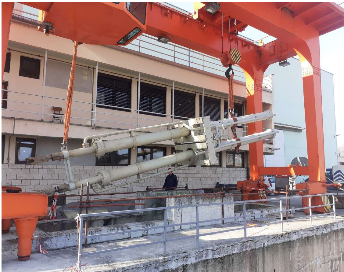
Slika 4.16 Izvlačenje servomotora portalnom dizalicom
