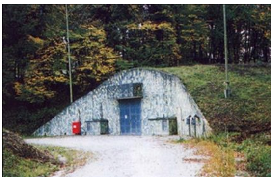
Slika 6. Skladišni objekt vrste U-20
