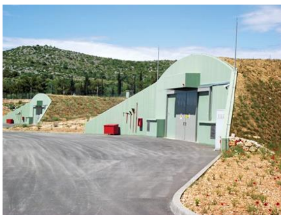
Slika 7. Skladišni objekt vrste PU
