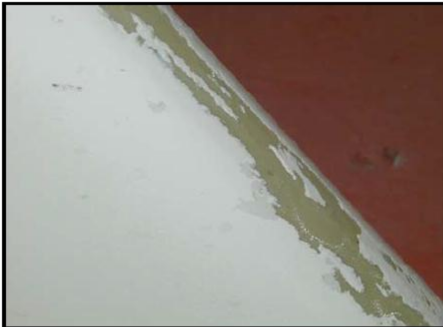
Slika 49. Erozijska šteta na vertikalnom stabilizatoru [3]
