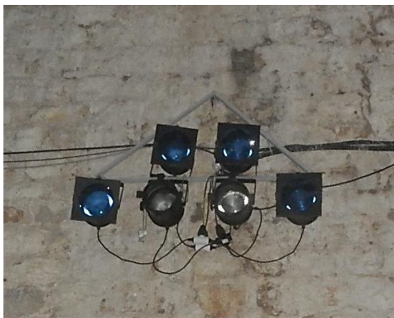
Slika 69: improvizirano vješalo s već montiranim reflektorima
