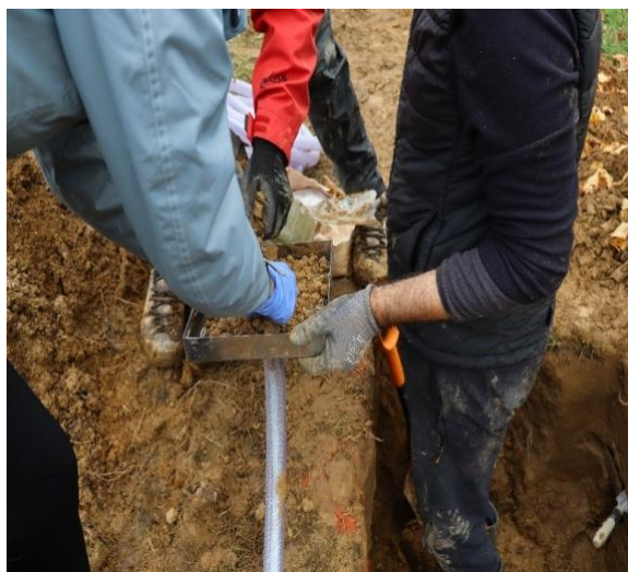
Slika3.2.3. Postavljanje tlačnog lizimetra
