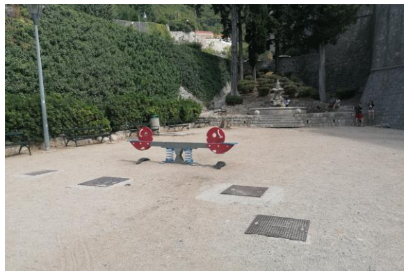
Slika 3.2.5.8. Park Pile – šahtovi kod sprava
