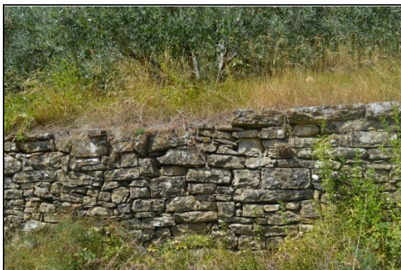
Sl. 67: Potporni zid
