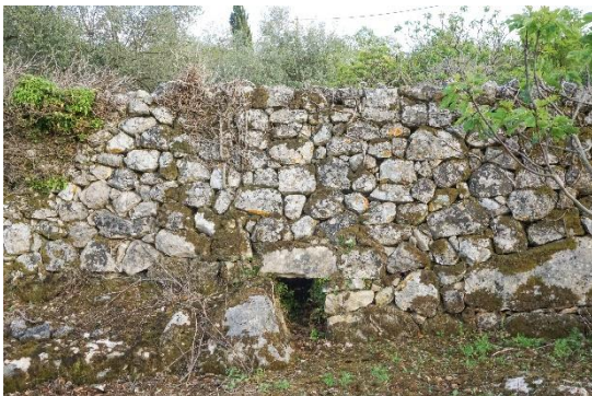
Sl.7.6.7. Prolaz u podzidu za odvod vode
