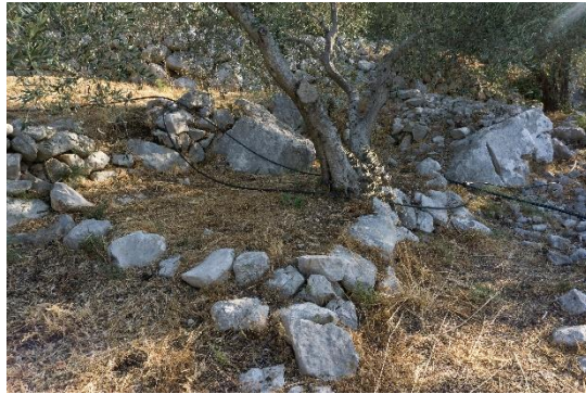
Sl.7.25.6. Manja terasa podzidana jednim redom kamenja
