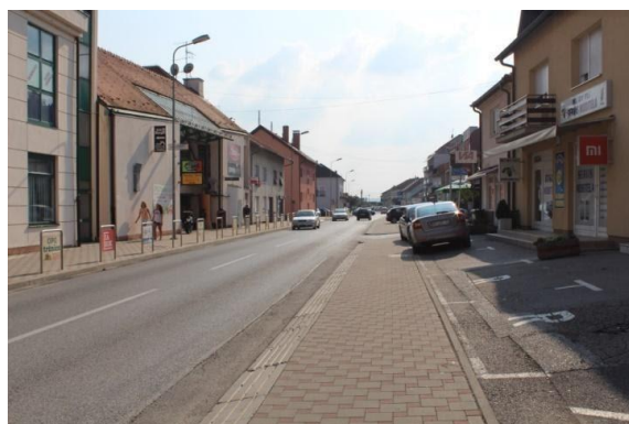
Slika 35_betonska površina uz prometnice
