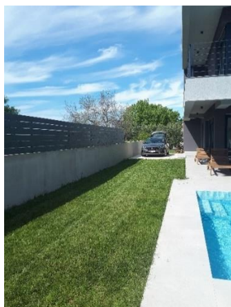
Slika 12 Zid s ogradom
