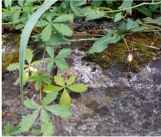
Slika 2.2.23. Biološka kolonizacija - bilje, mahovina, lišajevi (svijetlo sivo) i alge
