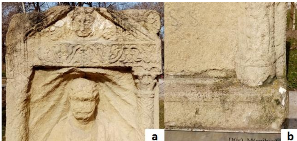
Slika 3.3.4.1 Spomenik Egnatuleja Florentina. a) prljanje; b) biološka kolonizacija algama i lišajevima.
