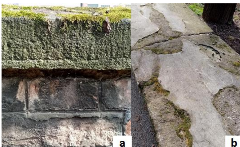
Slika 3.3.3.2. Istočna ograda: a) biološka kolonizacija algama i mahovinama, diferencijalno trošenje, pojava tafona, crna kora i prljanje; b) površinsko odvajanje, delaminacija i prsnuće.
