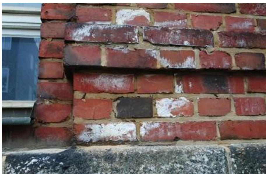
Slika 2.2.18. Promjena boje i taloženje - diskoloracija kamena i cvjetanje Izvor: Siedel, 2018.
