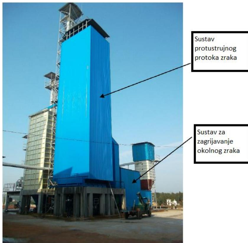
Slika 8. Prototip sušare s protustrujnim protokom zraka
