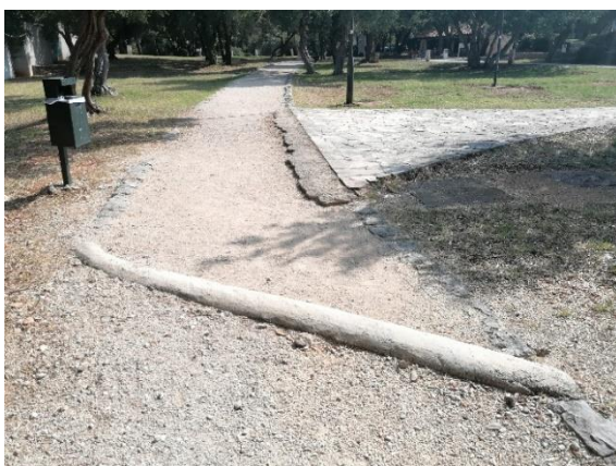
Slika 3.2.2.7. Park Babin kuk – neugledni i opasni spojevi staza
