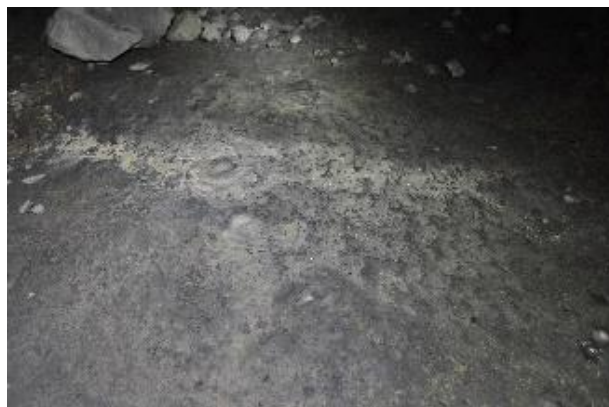
Slika 6.2.1.10.: Novi bijeli kalcit na podu izloženom vatri
