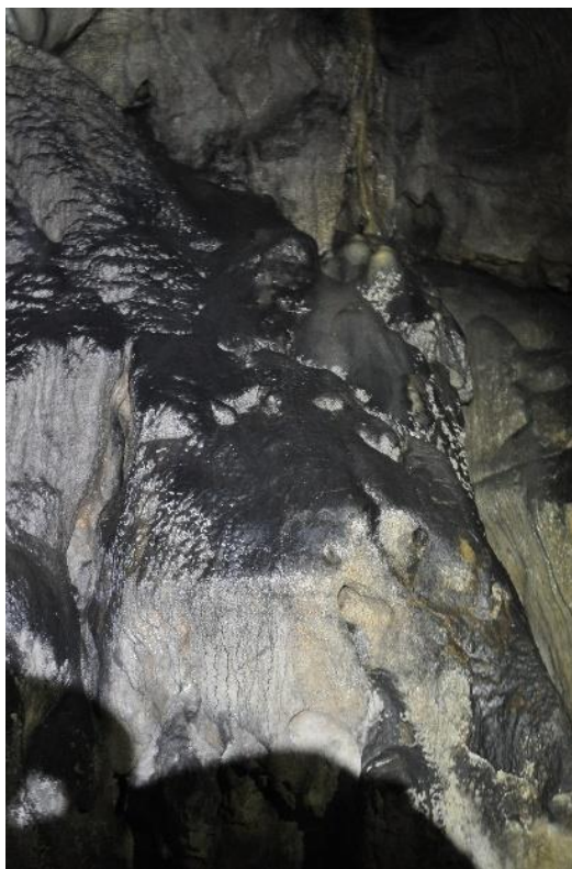
Slika 6.2.2.9.: Vatrom oštećene stijene
