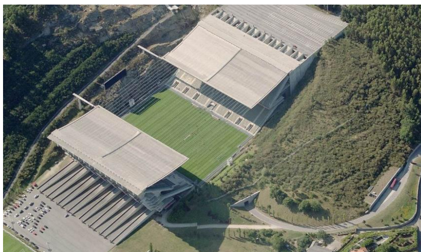
Slika 3. Stadion Braga prilagođen eksploatiranim stijenama, Portugal Izvor: Arhitektonske razglednice
