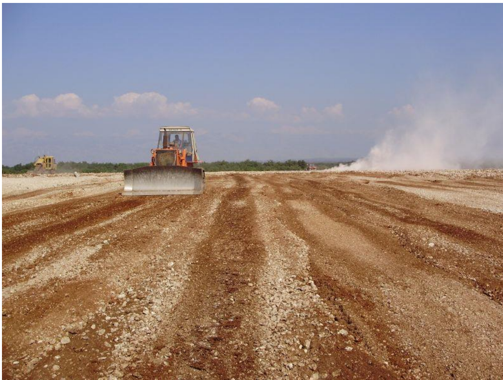
Slika 6. Niveliranje terena ( Izvor: Rajner Perica)
