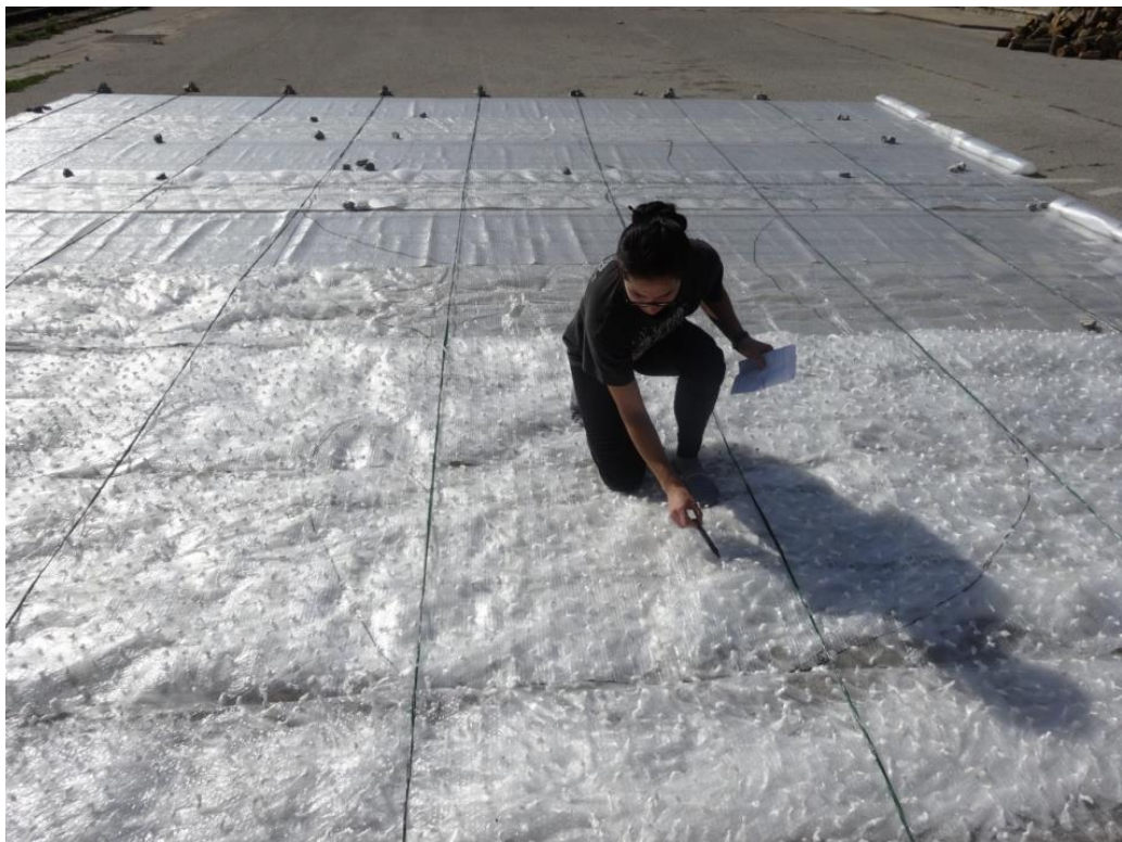
Fotografija 16: Precrtavanje sheme na stvarnu dimenziju plahti 1
