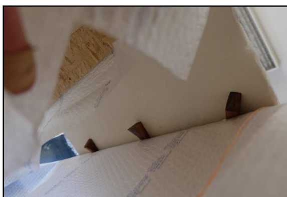
Slika 151. Umetanje drvenih kajli (pogled odozdo) koje su korištene za namještanje dijelova fragmenta u istu razni prije njihovog konačnog spajanja.
