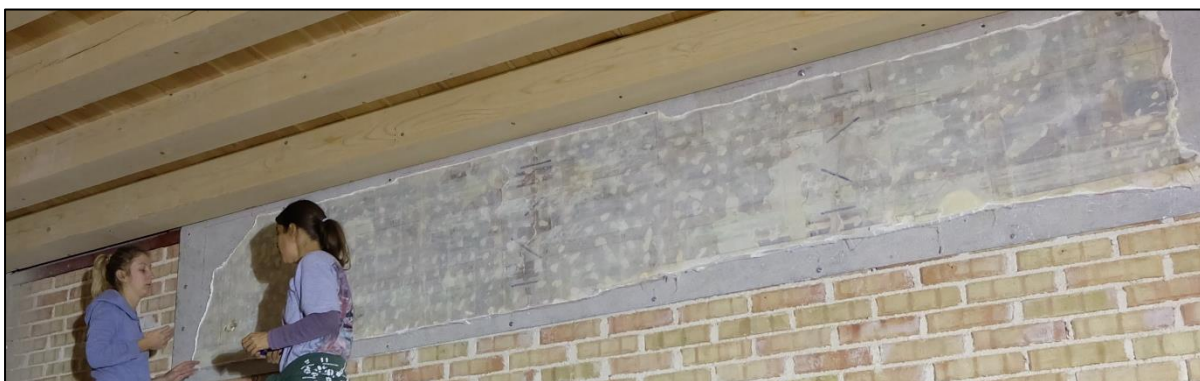
Slika 174. Fragment zidnog oslika s pokretnim nosačem postavljen vijcima na nepokretni nosač - novosagrađeni zid (južni dio zapadnog zida).
