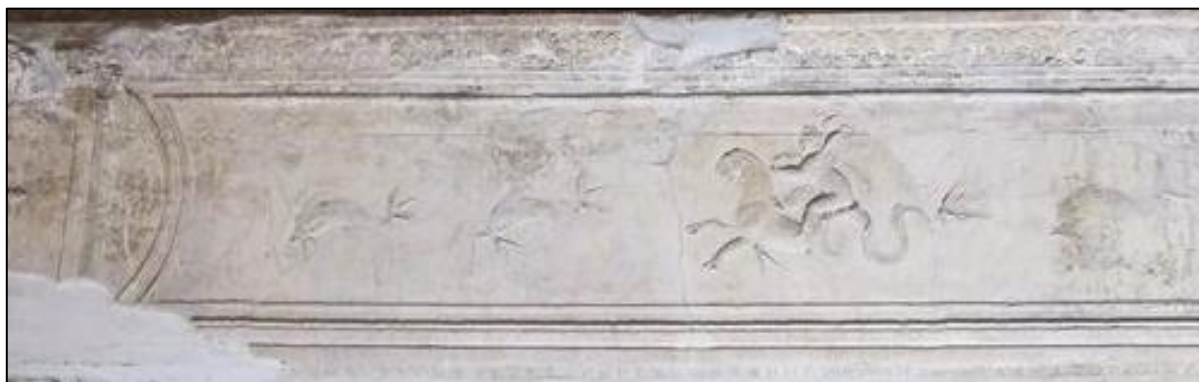
Slika 83. Komparativan primjer friza izvedenog u stucco tehnici. Friz se nalazi na zidovima frigidariuma (prostorija u kojoj se nalazi bazen s hladnom vodom) u rimskoj kupelji na arheološkom lokalitetu Pompeii (Italija).
