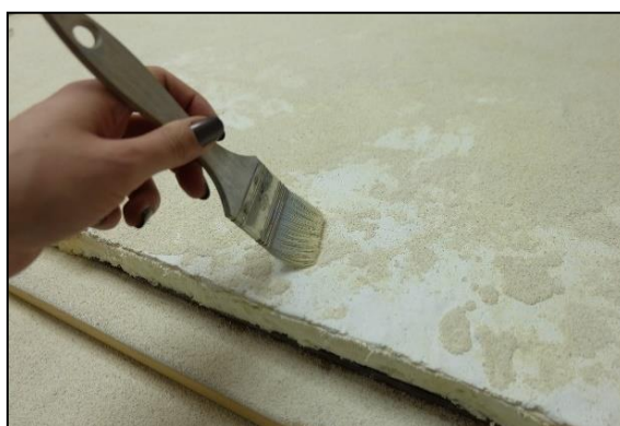
Slika 141. Otprašivanje nevezanih zrnca agregata nakon sušenja prvog sloja vapnenog kazeinata.
