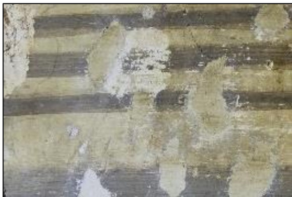
Slika 187. Testno područje u donjem desnom uglu fragmenta. Žbukane nadoknade tonirane su lazurnim nanosom lokalnog tona.
