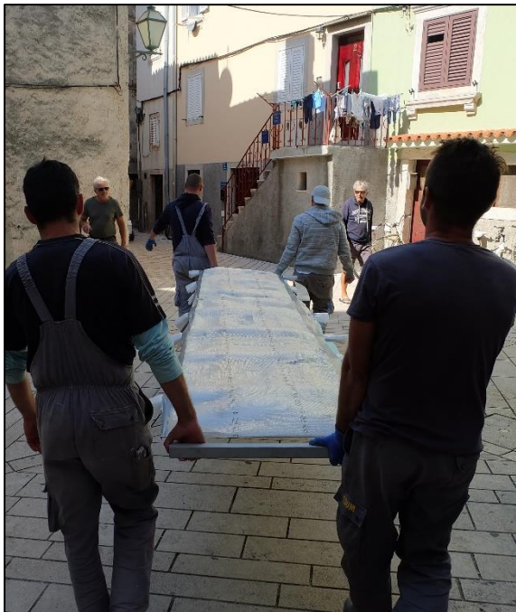
Slika 171. Prenošenje fragmenta postavjenog na pokretni nosač ojačan čeličnom ukrutom do kuće Moise.
