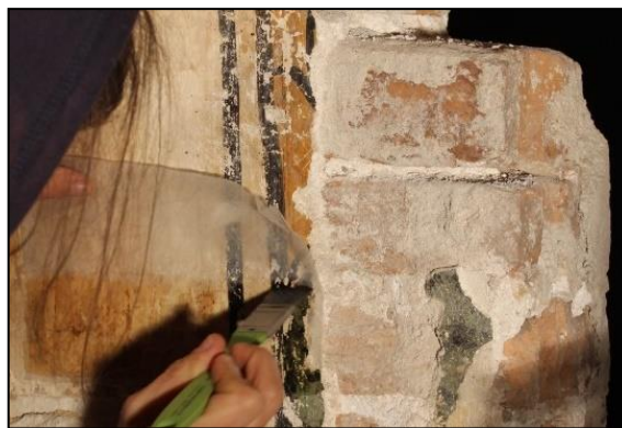
Slika 117. Nanošenje japanskog papira (dio postupka nanošenja facinga ) na probno područje gdje je ispitan učinak odvajanja zidne slike od nosača razgradnjom zida.
