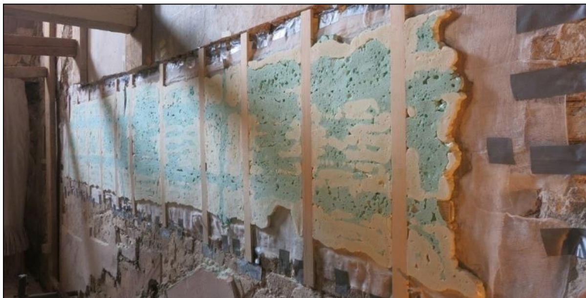
Slika 123. Privremeni nosač od mreže drvenih letvica. Prostor između njih ispunjen je poliuretanskom pjenu koja je nakon sušenja stanjena na njihovu razinu.
