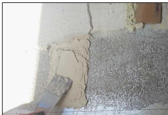
Slika 160. Nanošenje vapnene žbuke na sloj vapnenačkog drobljenca zalijepljenog epoksidnim ljepilom.
