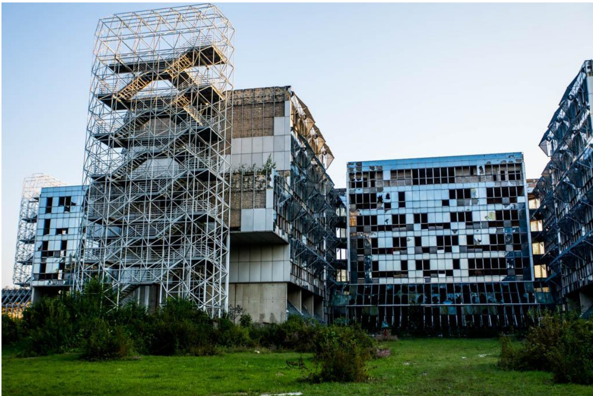
Slika 29 Sjeverna strana kompleksa
