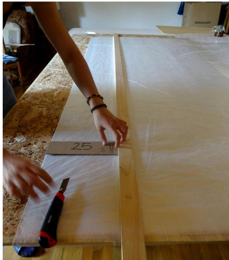
Fotografija 11: Mjerenje potrebne širine najlona prije rezanja
