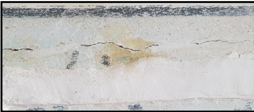
Slika 78 Detalj, mrlje nastale nakon reagiranja injekcionog materijala s nečistoćama prisutnima u izvornoj žbuci
