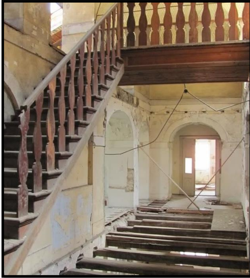
Slika 16 Drveno stubište koje povezuje treći kat s potkrovljem
