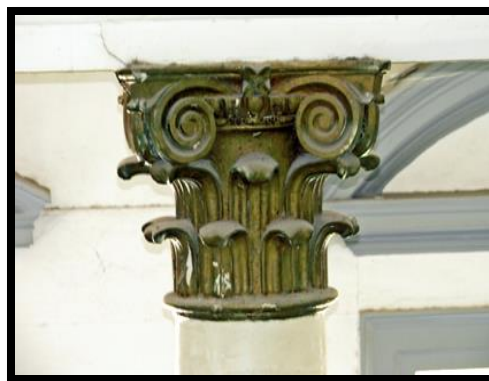
Slika 20 Glavno stubište, korinjski kapitel
