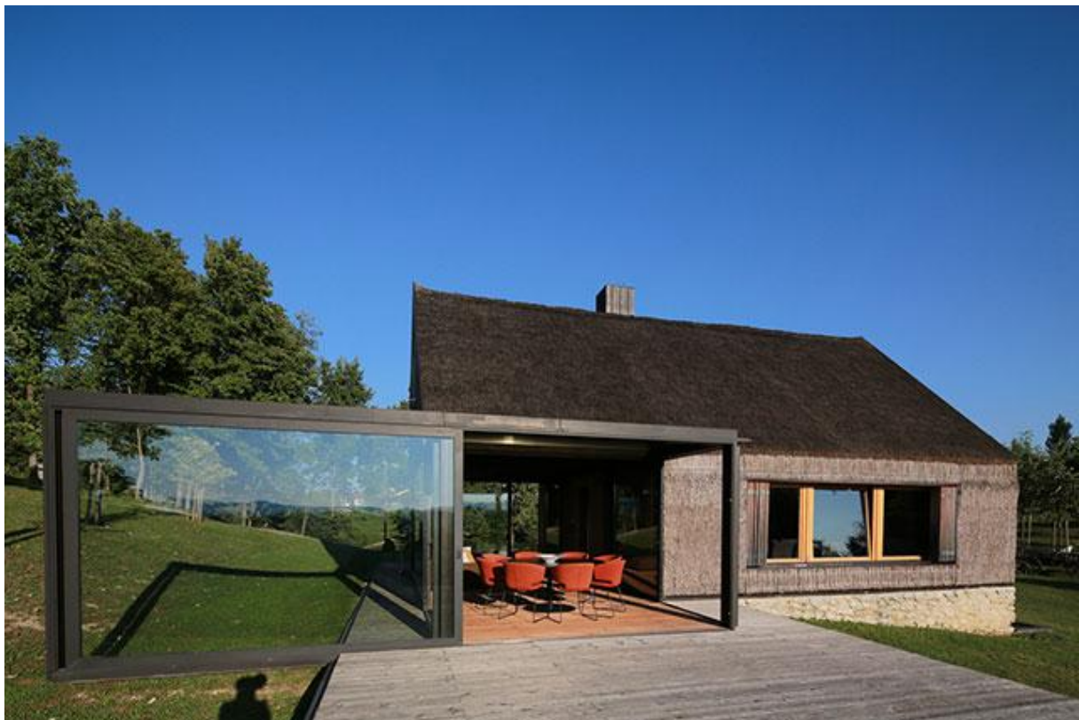
Slika 36. Kuća za odmor „Zagorska hiža“ arhitekt Davor Mateković, Kumrovec
