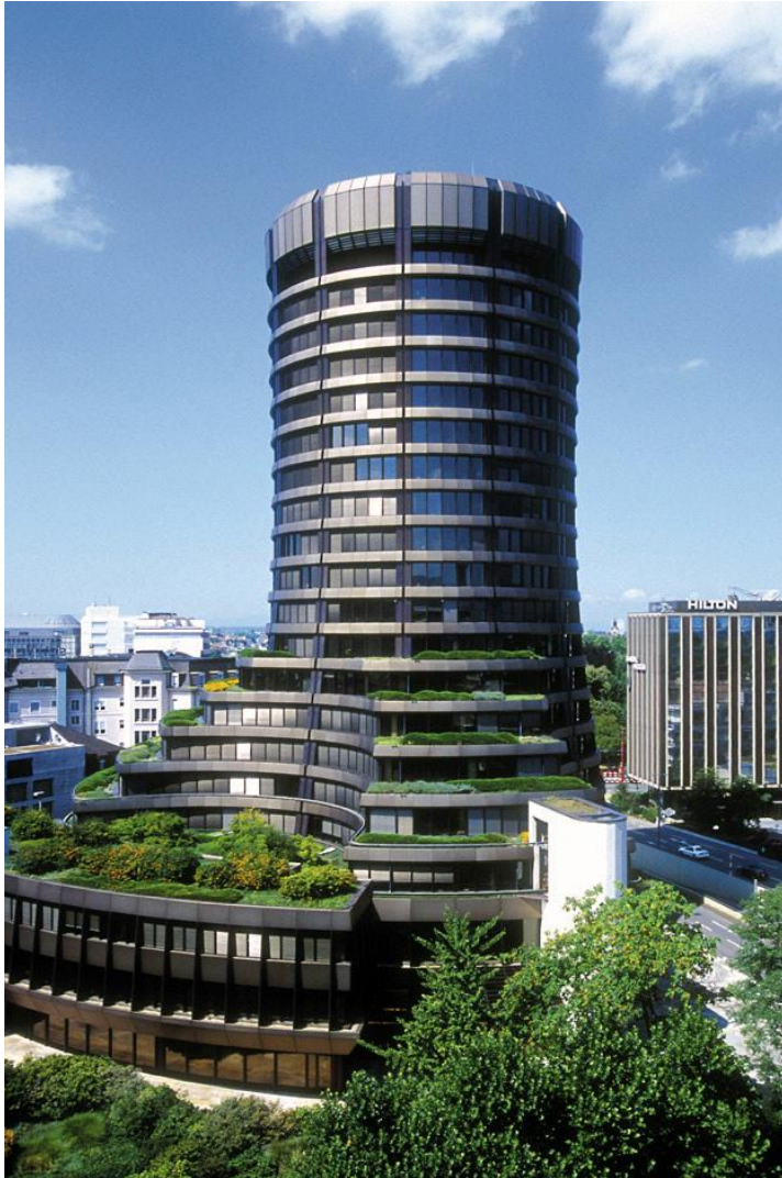
Slika 1 Zgrada Baselskog odbora – Švicarska https://www.riskcompliance.biz/news/finalising-basel-iii-reforms/ Pristup 20.09.2024.
