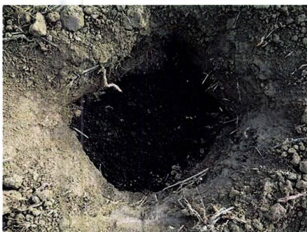
Slika 4. Iskopana jama za sadnju
