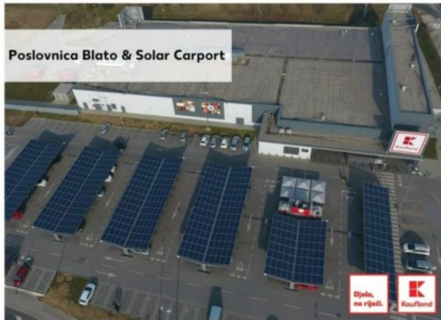
Slika 7. Kauflandov Solar Carport
