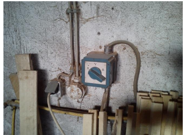
Slika 3.7. Preklopka zvijezda-trokut u pogonu
