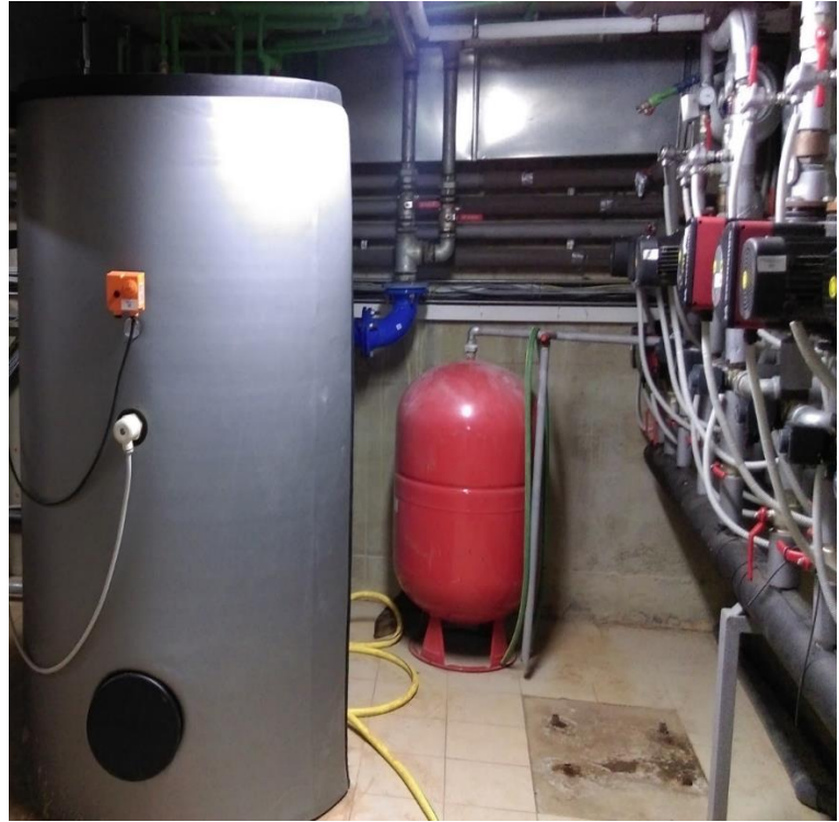
Slika 2.3. Bojler i ekspanzijska posuda
