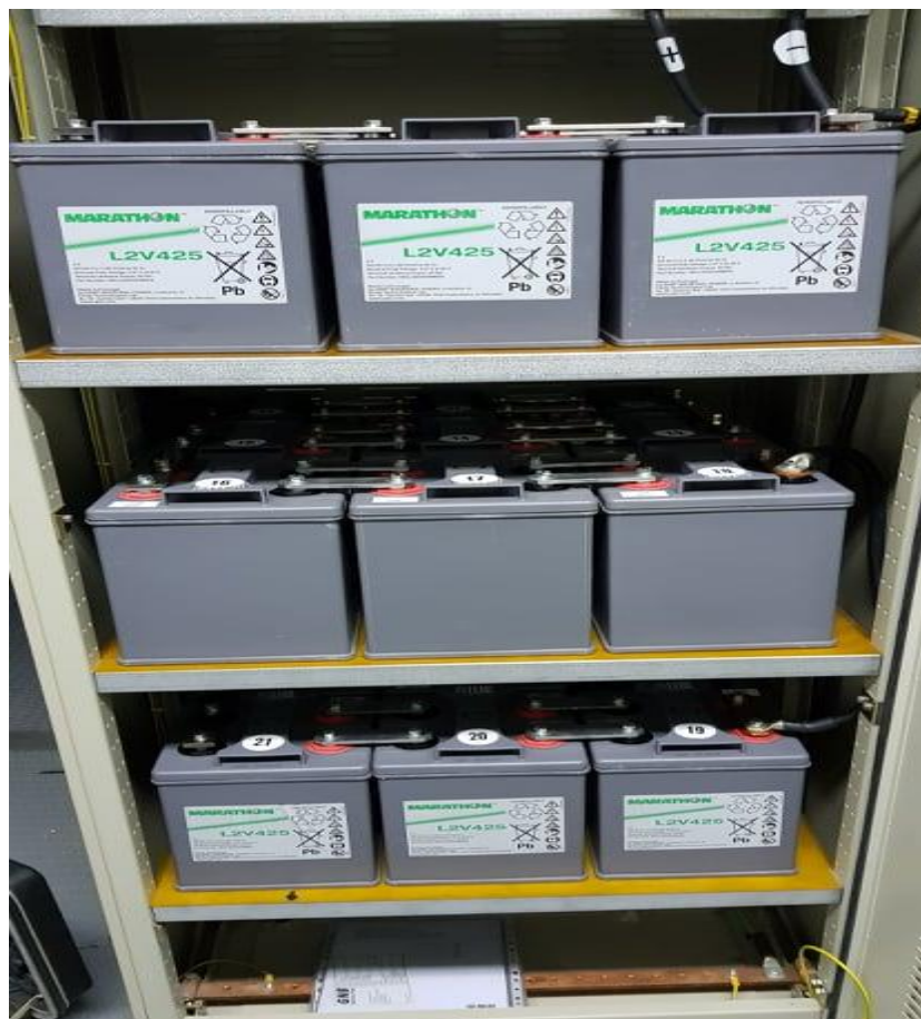
Slika 3.4. VRLA baterije
