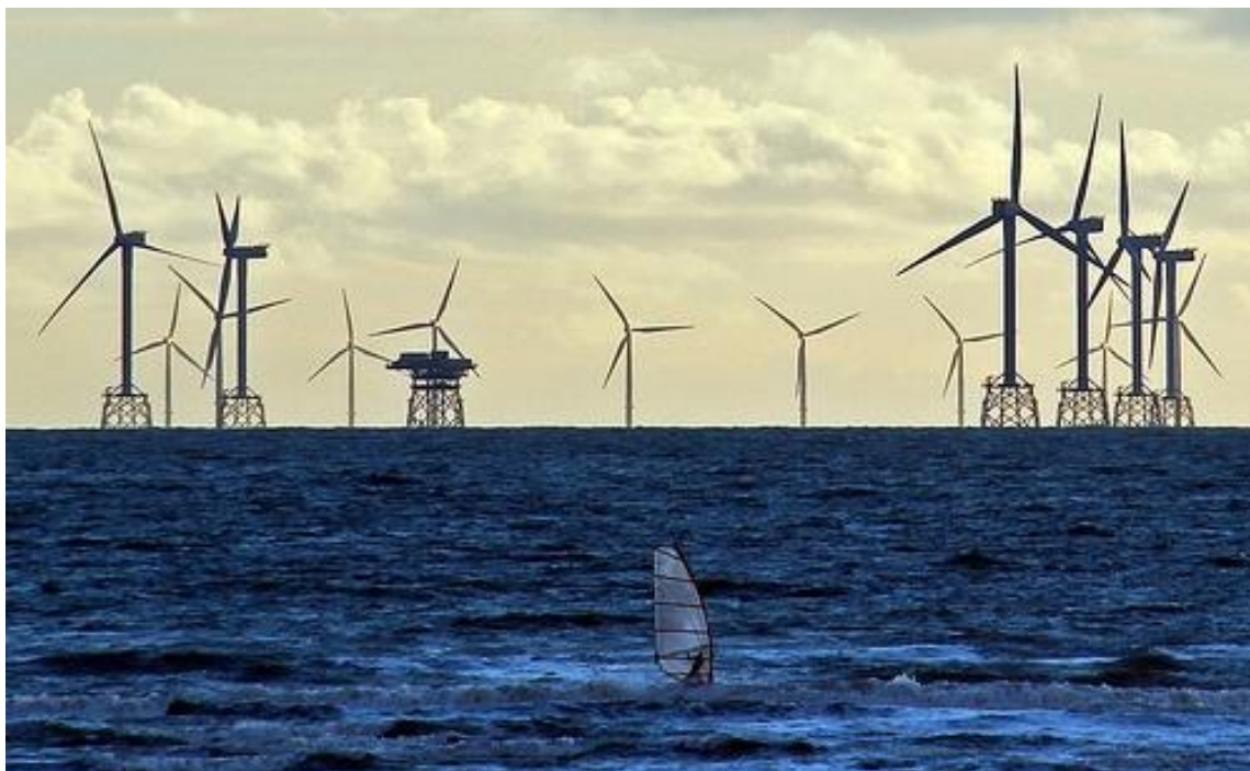
Sl. 4.8. Vjetroelektrana na pučini u Walney-u, Engleska [17]
